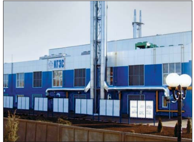
Рис. 4. Когенерационная газопоршневая электростанция
